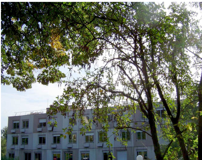
Bâtiment des services Médecine et Soins de suite et de réadaptation
