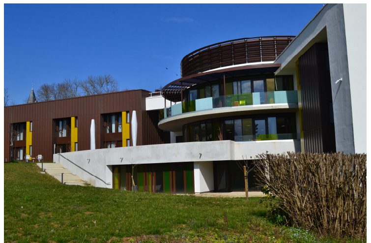
Bâtiment des services La Doue, La Dolive et La Seille Du PASA
