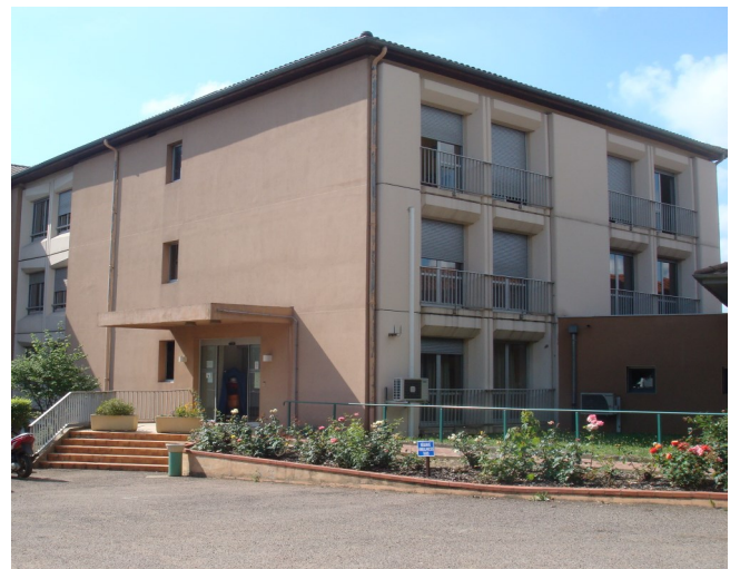
Bâtiment des services Saint Philibert, Accueil de jour et UVP - [EHPAD]
