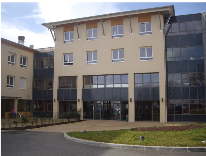
Entrée du CH Belnay Bâtiment La Villae
